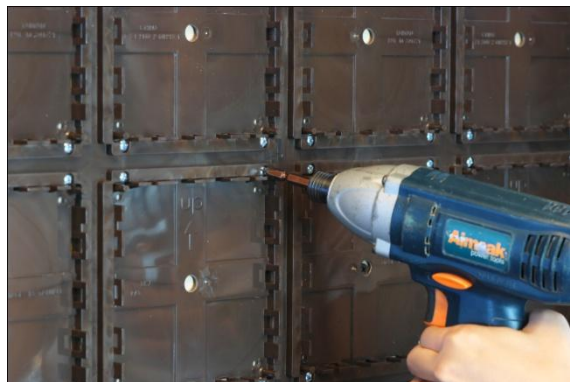
鎖上螺絲將底板固定
