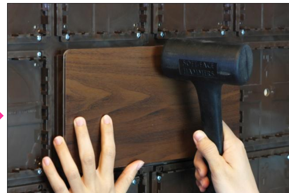
用橡膠槌敲打面板四周，使之與底板結合
